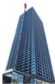
武蔵小杉計画(地上53階、地下3階)では、地下躯体や地上躯体のPCa化計画と、ほぼ全てのPCa部材を製造(床PCaを除く)
